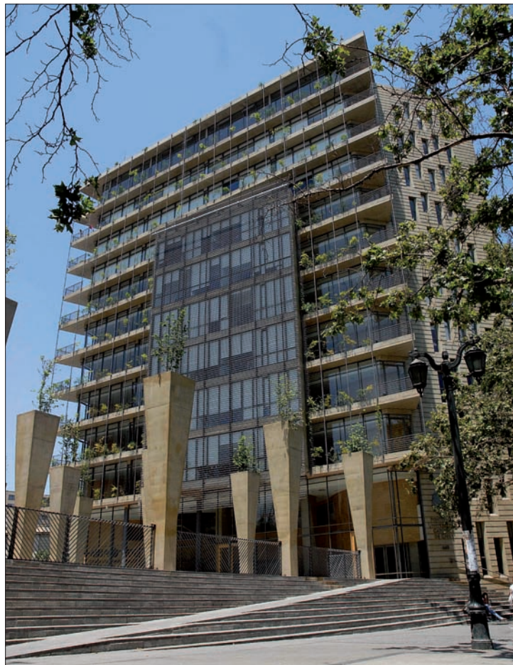
NUEVA CASA: El noveno piso del edificio Patio Alameda, ubicado a pasos de la Casa Central de la UC, es la sede de nuestro nuevo LL.M.
